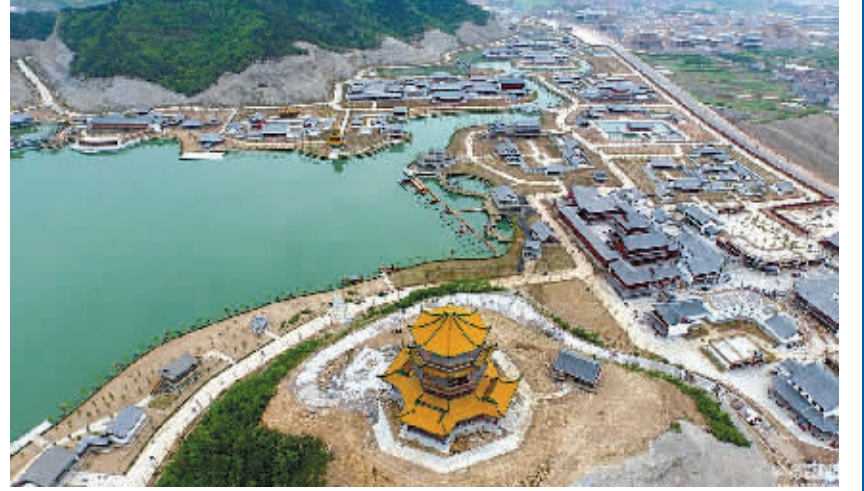
图为建设中的横店“圆明新园”。
