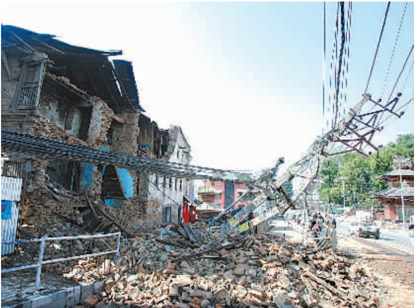
这是4月27日拍摄的尼泊尔首都加德满都一处在地震中损坏的房屋。(新华社发)
