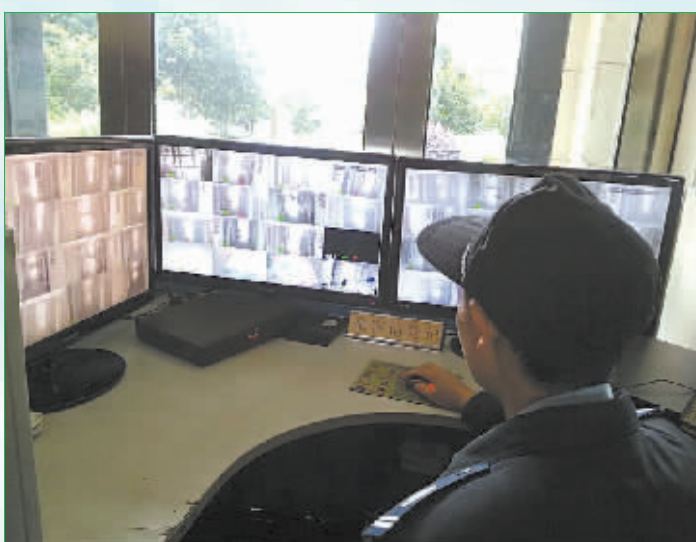
小区在各楼道均安装了监控摄像
