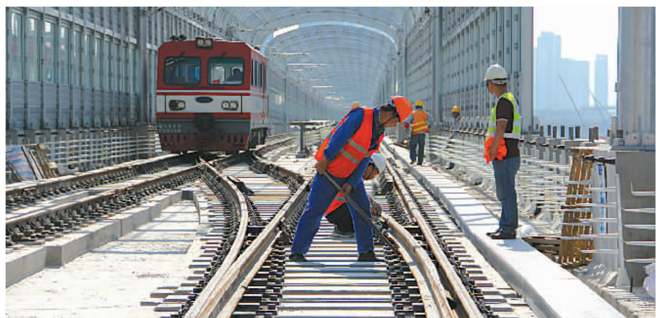
施工人员正在检查轨道扣件安装质量。
