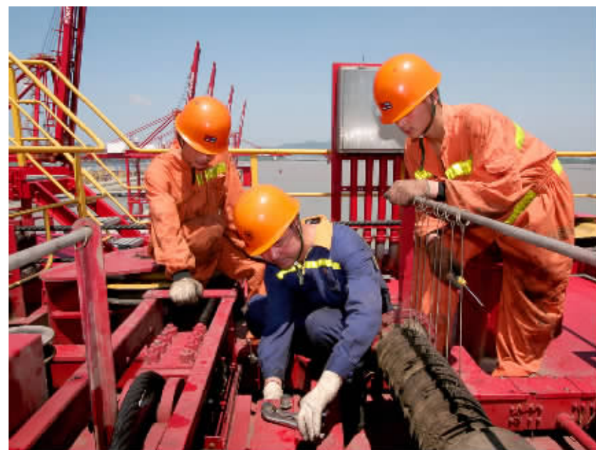
图为港吉公司维修工人正在桥吊上用国产零部件替换进口零部件。
