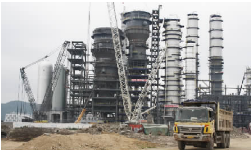
图为中海油大榭石化馏分油项目环保装置建设现场。（记者 李平 摄）
