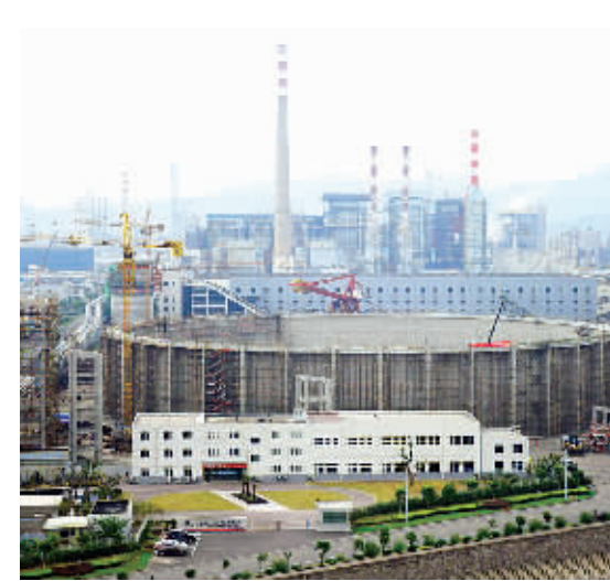
正在建设中的1号煤仓。(冯璋 陈婷 摄)
