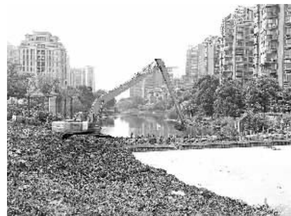
图为施工现场。（张燕 摄）
