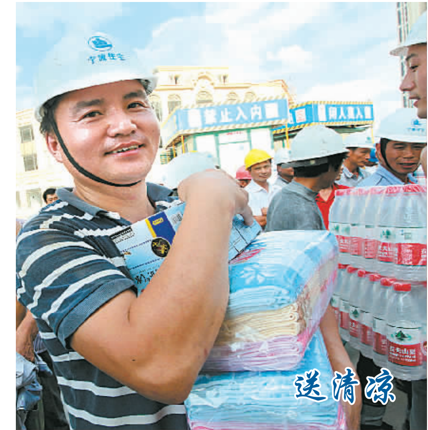
昨天,市区最高气温达35.9℃,在鄞州区宁波住宅建设集团东南片建设工地上,各班工人在领取集团送来的夏令用品。高温来临,该集团组织巡回小分队向所属的26个项目部开展“送清凉进工地”活动,并落实露天作业相应的避高温作业规定。(记者 徐文杰 摄)
