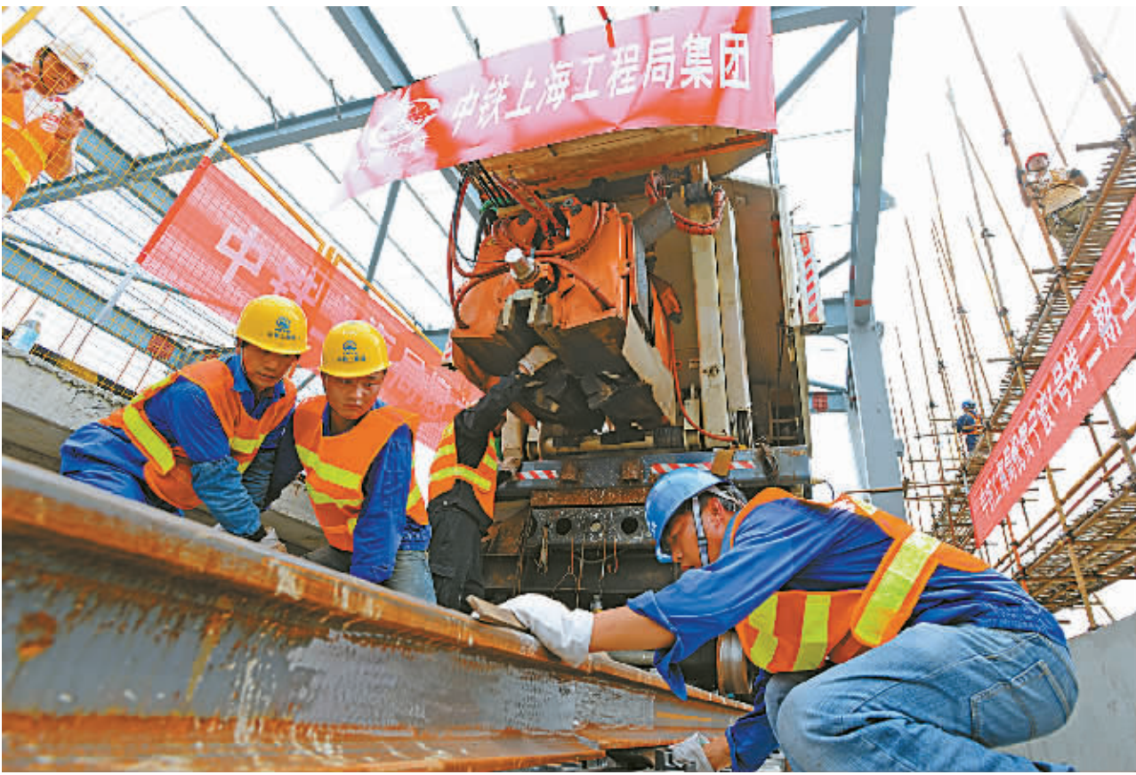
施工人员进行最后一处钢轨合龙接头焊接。
