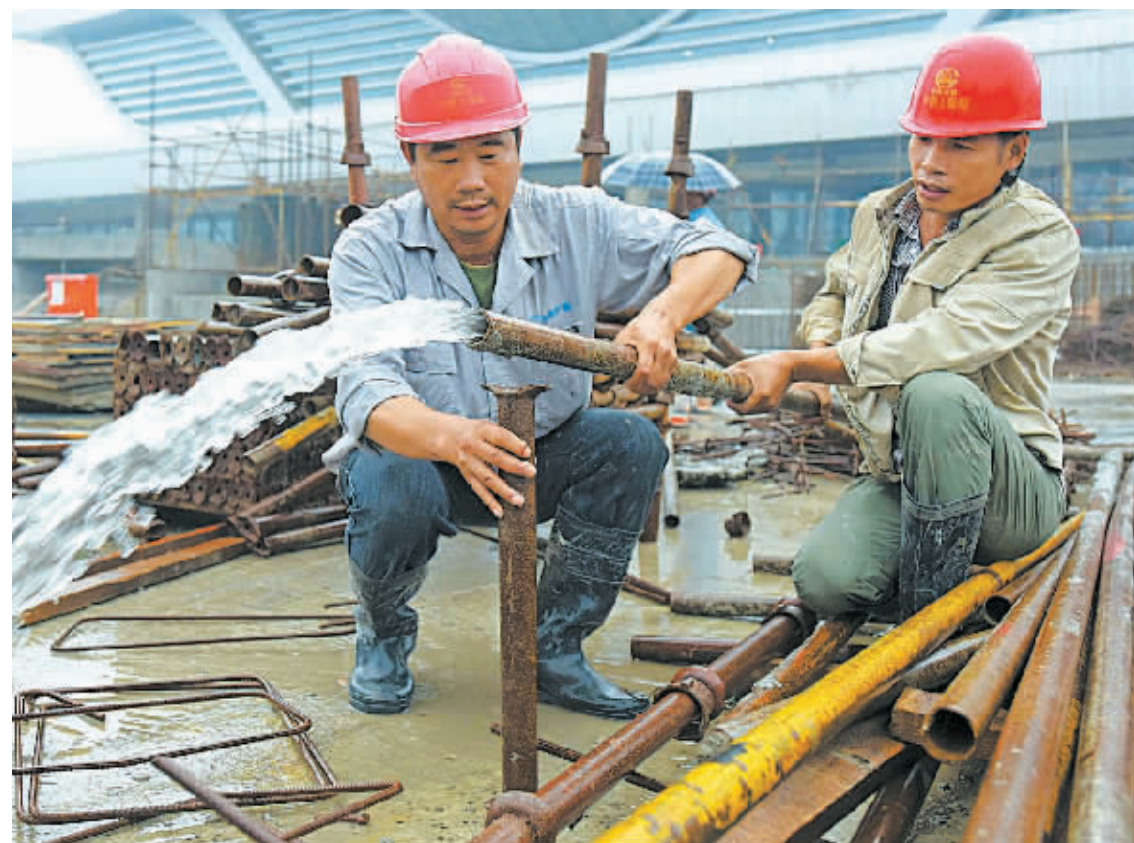
昨天,铁路宁波站北广场地下室工地施工人员在排水。汛期,为不影响北广场地下室铺装、装修工程,施工方组织应急抢险队,并安排20多台强排泵在施工现场抽除积水,确保工程如期推进。(徐文杰 张黎升 摄)
