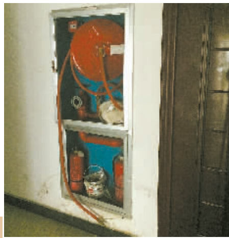
消防栓里的水被住户临时“征用”。(王伊婧 摄)
