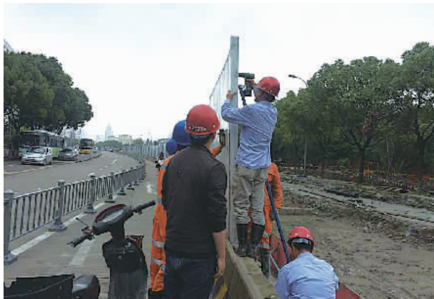
图为施工人员正在拆除围挡。
