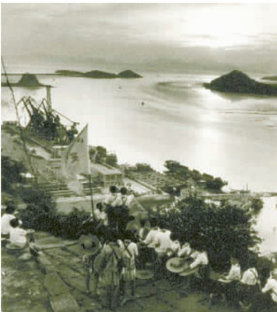
1978年,镇海港万吨级煤炭专用码头竣工,为宁波港第一个万吨级码头。
