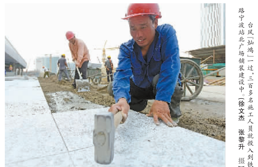
路宁波站北广场铺装建设中。(徐文杰 张黎升 摄)
