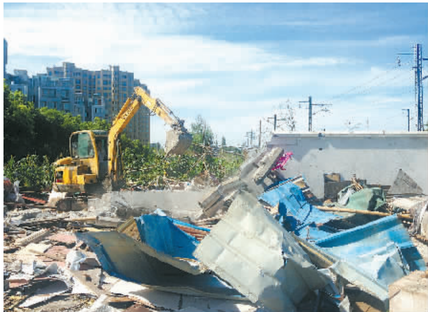
江北“两路两侧”拆违现场。(单玉紫枫 摄)
