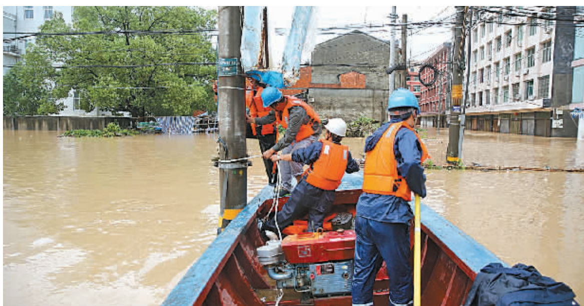
八月九日，在遭受水灾的温州平阳县，供电公司抢修人员乘舟舟赴现场，恢复居民用电。(新华社发)
