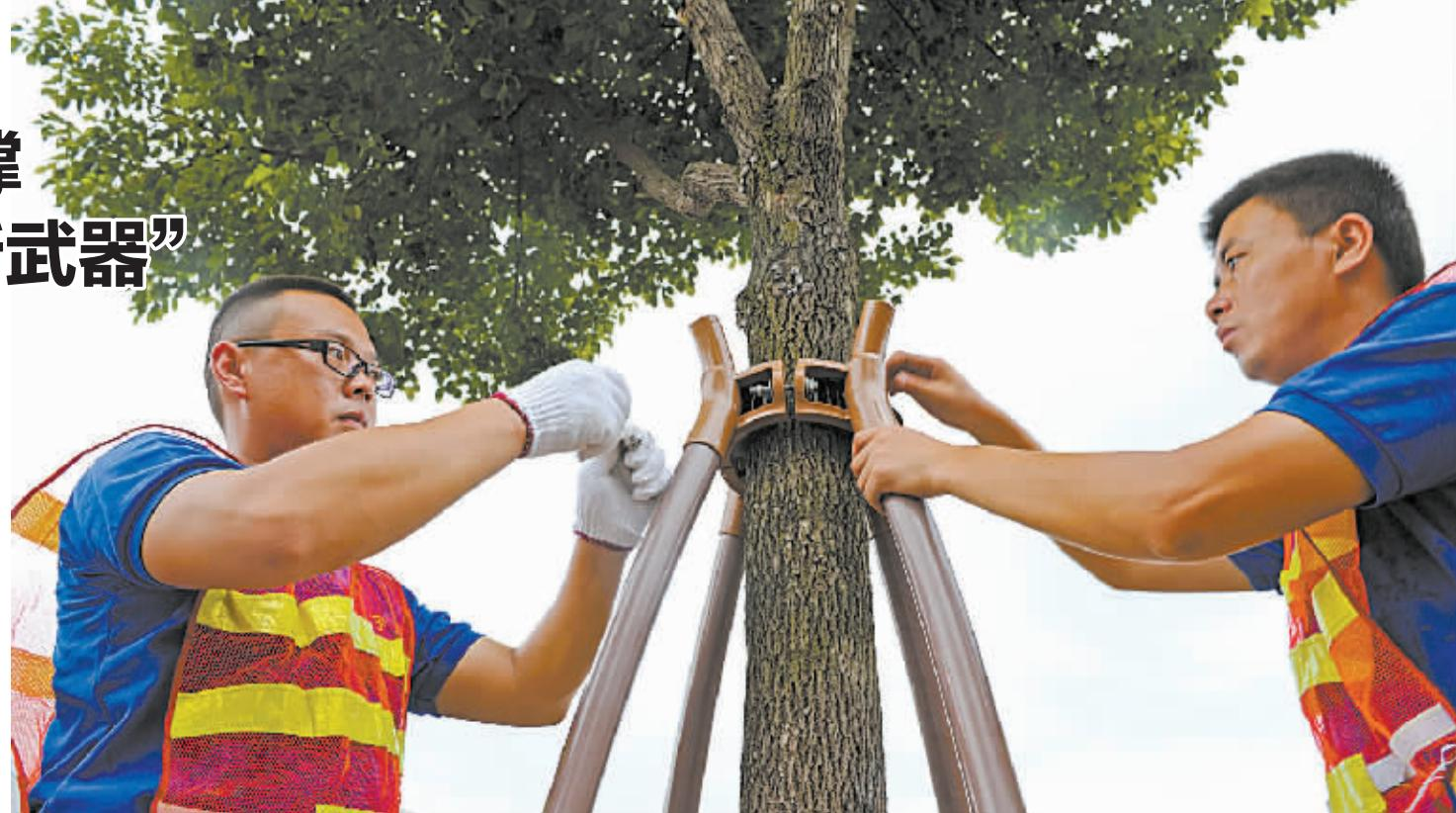
昨天下午，鄞州区城管局园林养护工人正在惠风东路安装新型树木支撑架。据悉，此次试点安装的110余套支架采用复合材料，并配上夜间景观灯效果，在固定性、美观性等方面有较大提升。
