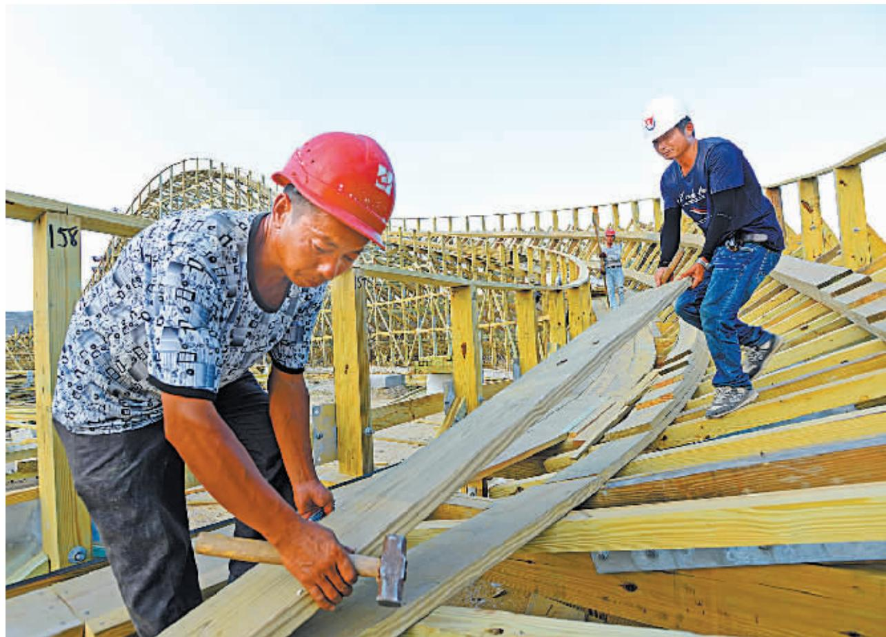
连日来，在杭州湾新区宁波·华强中华复兴文化园一期项目非物质文化博览园，施工人员正在抓紧进行木质过山车的最后拼装。作为博览园的重头戏之一，该条由美国引进的过山车道全部采用木材搭建而成，轨道全长995米，预计今年10月可投入使用，届时游客将体验时速90公里的360度大翻转、近90度高速垂直俯冲等惊险感觉。
