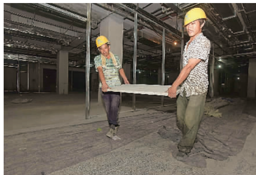
工人正在地下室作业。
