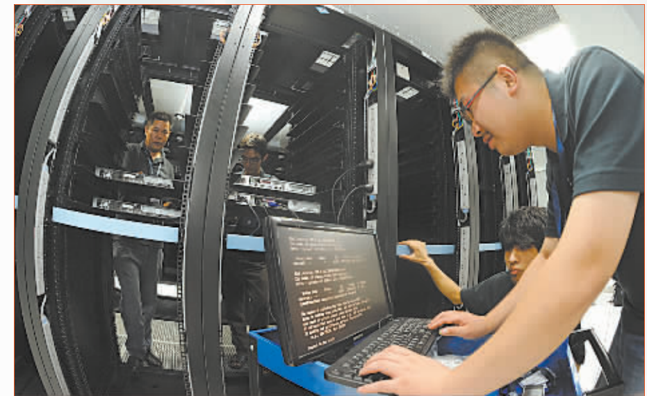
高新区数据中心。
