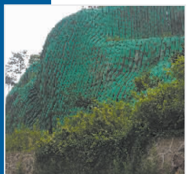
治理后的小港滨江汽车城南侧山体边坡。(孙吉晶 摄)
