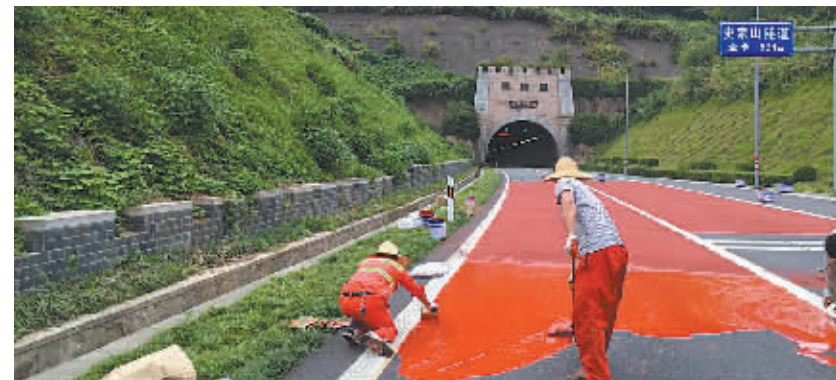
隧道口光线明暗差别大，司机在瞬间容易“致盲”，是事故的高发地段。象山公路管理段日前在隧道口采用彩色防滑路面，不仅对驾驶员起到警示作用，同时这种新型路面防滑系数高，能有效缩短刹车距离，防止路面开裂。因为工作人员在象山西线史家山隧道上行线洞口前施划彩色防滑线。（张燕 洪奇峰 摄）
