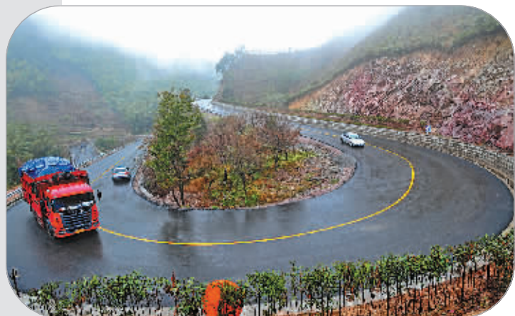
穿越四明山区的浒溪线改造工程完工。
