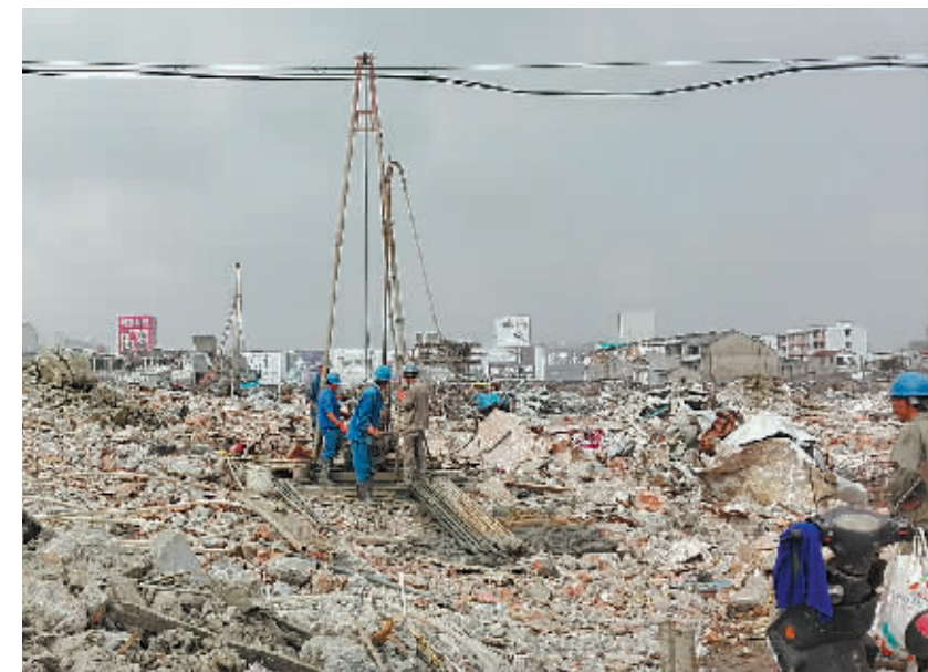
图为现代板材城拆除现场。(单玉紫枫 摄)
