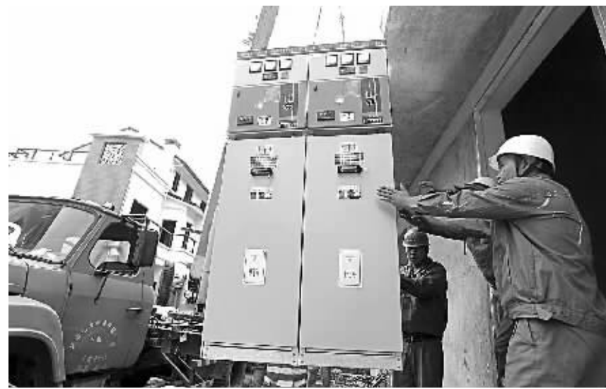
鄞州区供电公司员工日前在龙观镇李山村安装变压器,为该村11月初光伏电站并网发电迈出关键一步。李山村分布式光伏电站建成后,将成为目前全国规模最大的光伏发电村,344户用户预计年发电量50万千瓦时。
