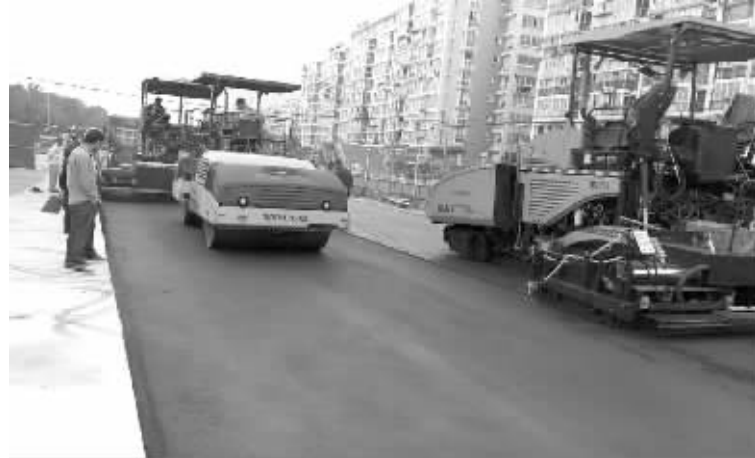
图为摊铺弹性沥青应力吸收层。(王岚 摄)
