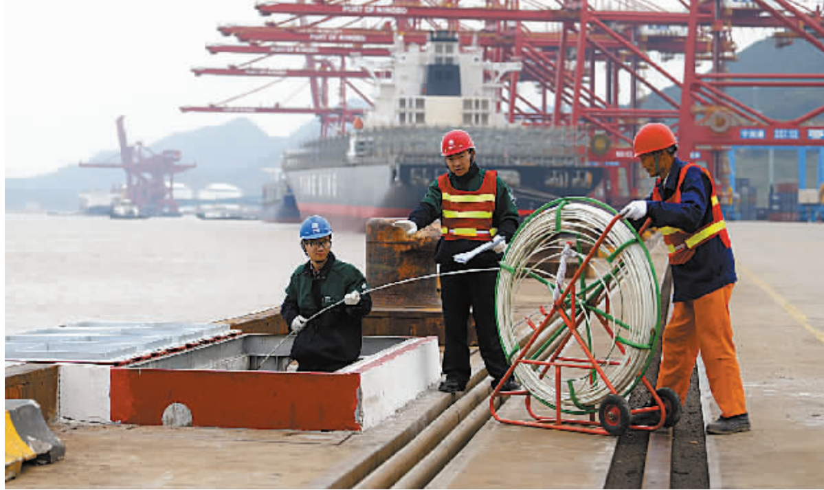
电力部门正在对高压港口岸电项目进行施工。（冯璋 王慕霖 摄）
