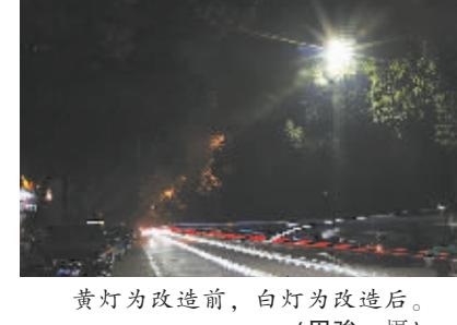
工作人员表示,在改造中将结合树木遮挡的实际情况,对路灯的挑臂、灯杆和灯具进行更改,通过增长挑臂、降低灯杆高度等措施,有效减少树木对灯光的影响,为市民出行更加安全、明亮、舒适的夜间出行环境。
