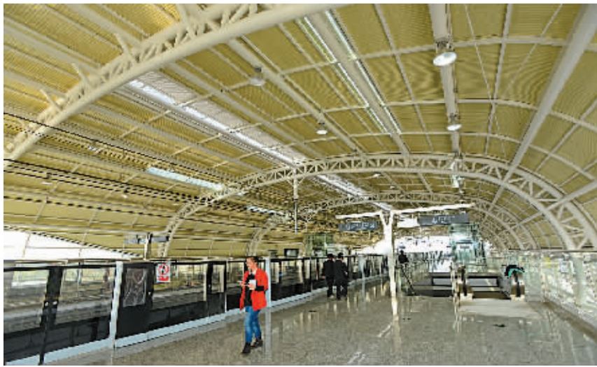
1号线二期鄞隘站内景。
