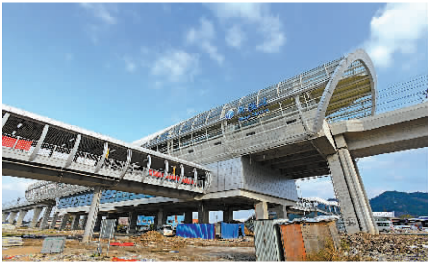
1号线二期高架车站外景。
