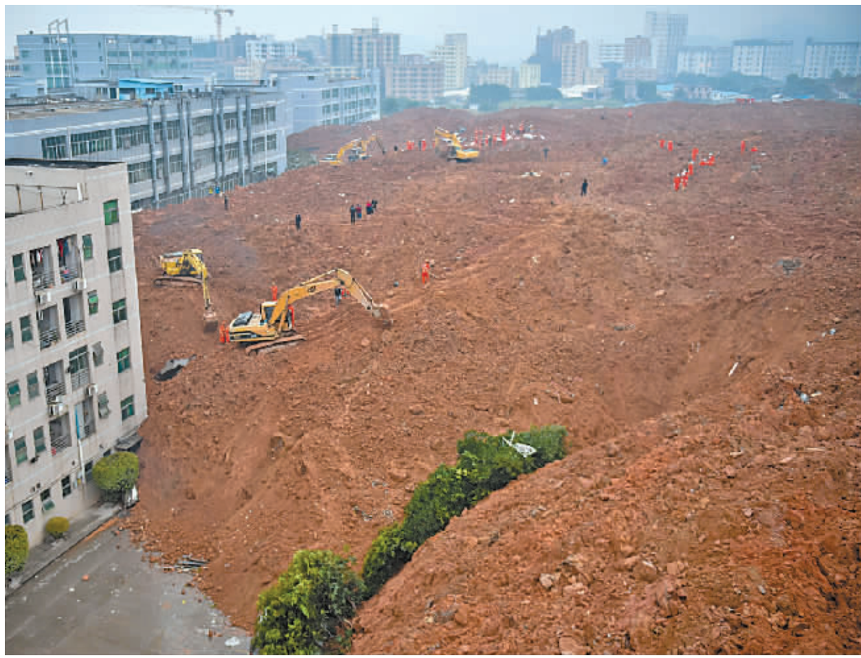
图为事故救援现场。
