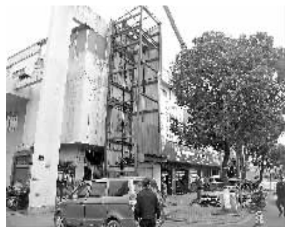
图为拆违现场。(董建亚 摄)
