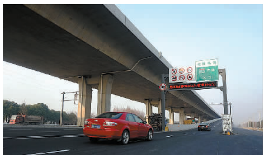
慈溪胜陆公路(胜山至横河段)高架桥通车。(记者 吴冠夏 摄)
