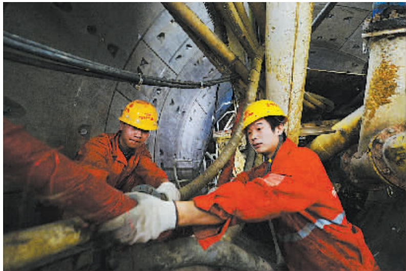
2015年12月31日，两名施工人员在隧道盾构机内作业。(新华社发)
