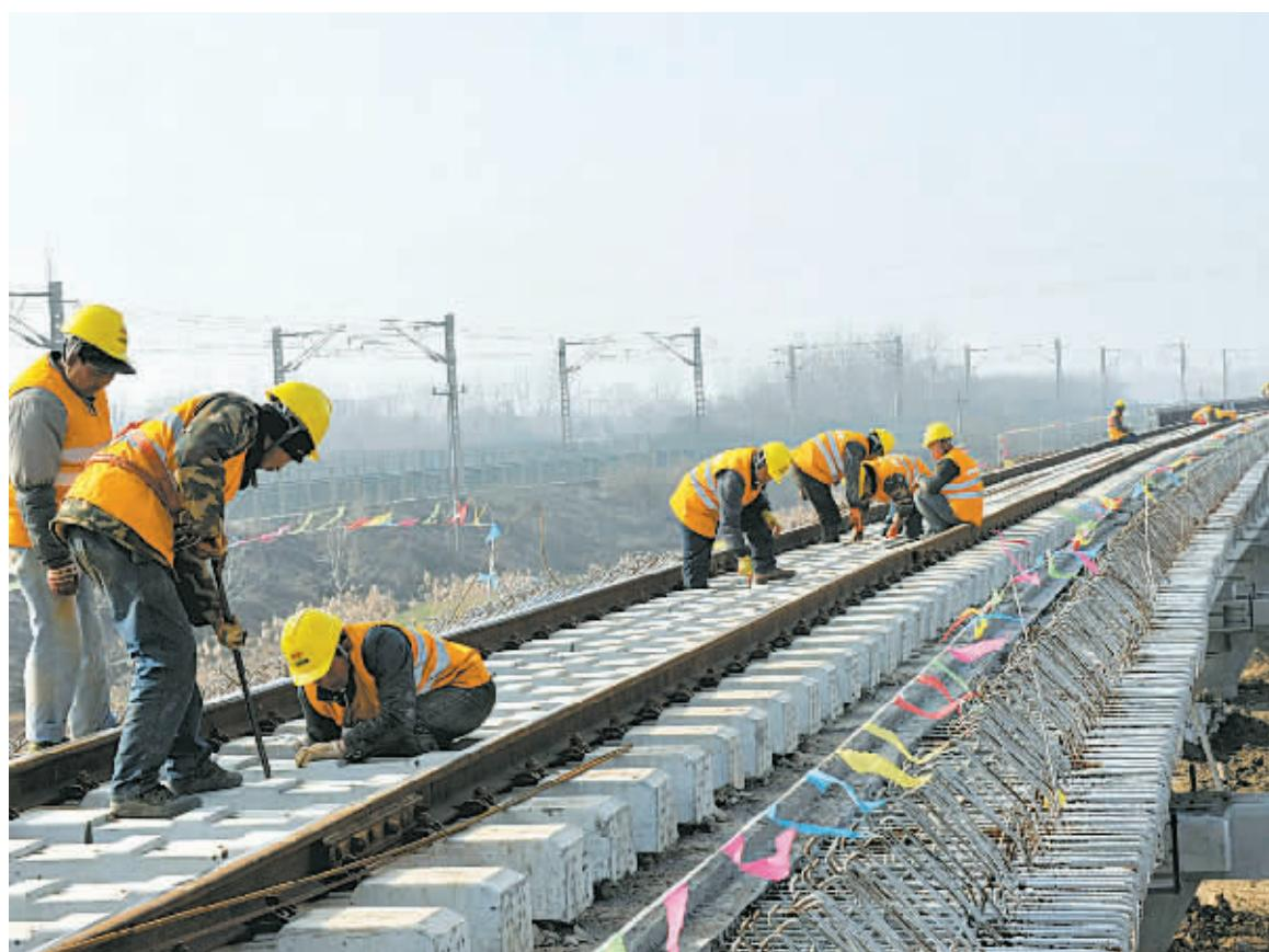
1月1日,中铁十一局施工人员在江苏连云港市连盐铁路轨道中间加固中筋以备浇筑。
