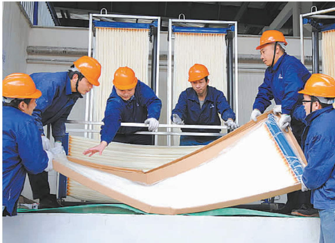
工作人员正在进行超滤膜安装。
