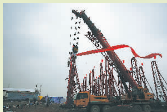
宁波机场三期扩建工程开工。(张燕 摄)
