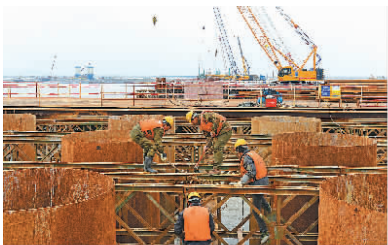
昨天上午，施工人员正在力洋港7号主墩平台上拆除贝雷片，这标志着三门湾大桥及接线工程开始进入下部施工阶段。(记者 徐能 摄)
