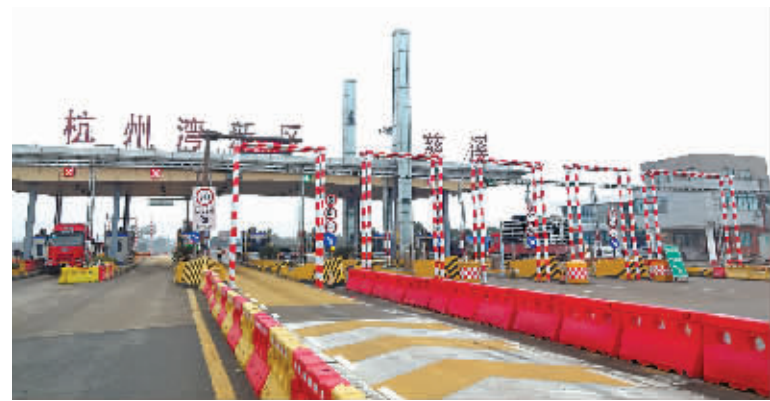
收费站出口通道的限高限宽架。
