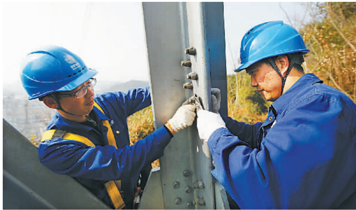
图为电力人员正在检修高压线路。
