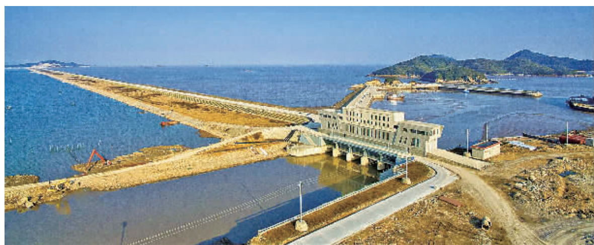
航拍下的围涂工程大坝。
