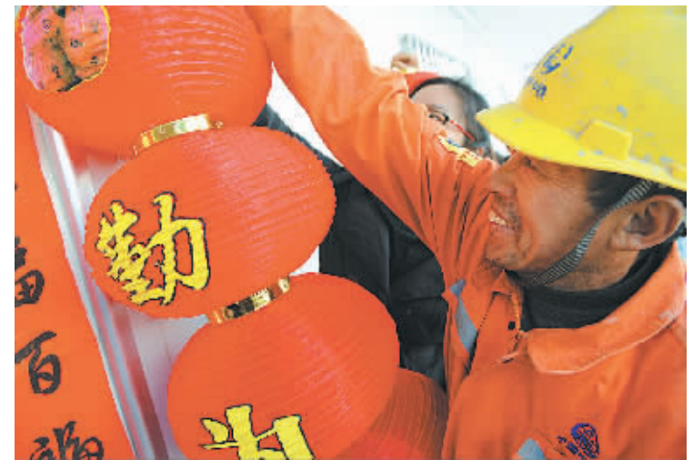
部分轨道交通建设者今年春节将放弃与家人团聚的机会坚持施工。昨天,鄞州钟公庙街道后庙社区的志愿者们来到轨道交通3号线中铁四局工人宿舍慰问建设者,与施工工人一起贴春联、挂灯笼,共迎新春佳节。(丁安 陈存萍 摄)
