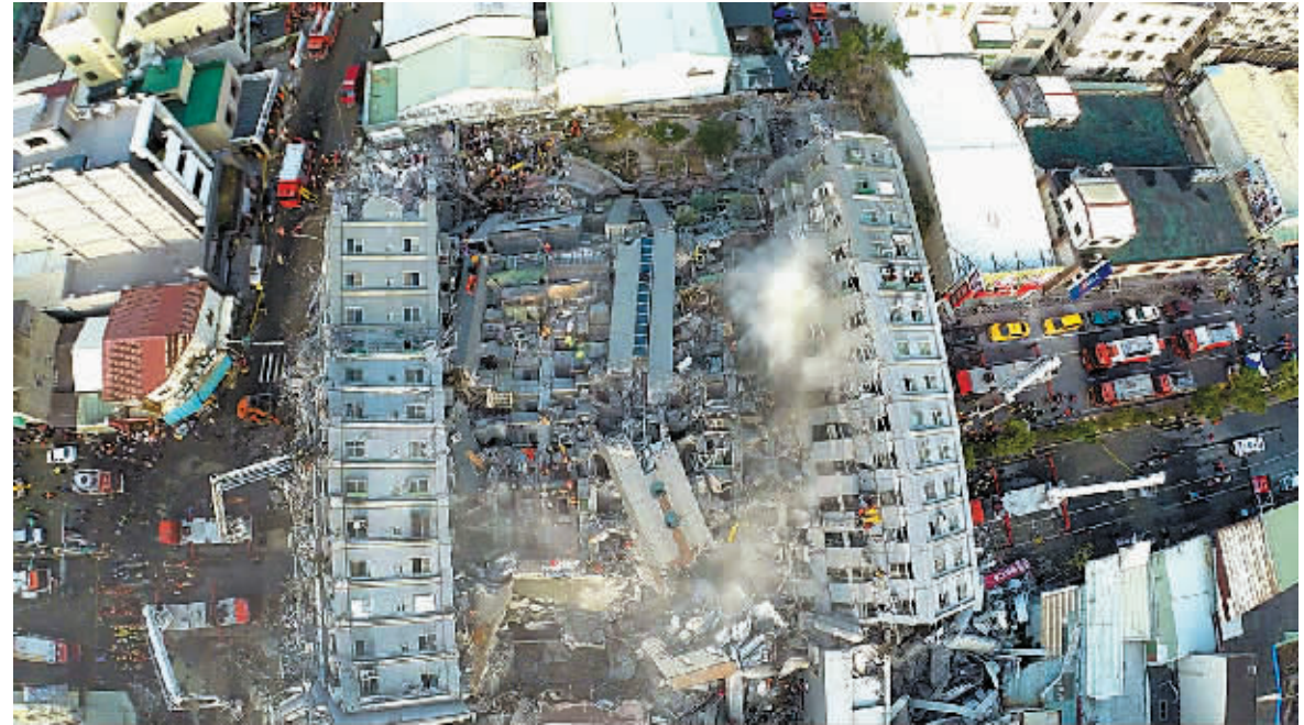
这是2月6日航拍的台南市永康区维冠金龙大楼倒塌现场。
