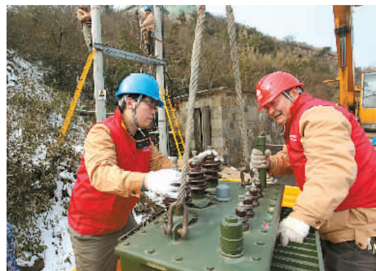
春节期间，鄞州供电公司6支应急小分队的50多名队员坚守岗位，随时待命，并做到安全、物资、车辆、服务“四到位”，确保节日期间安全用电。图为邱隘供电所应急队员近日正在海拔600余米的东吴镇太白山顶对一台变压器进行更换。(徐文杰 胡春华 摄)
