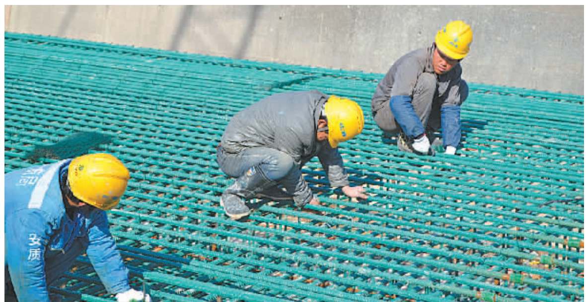
三门湾大桥建设现场。
