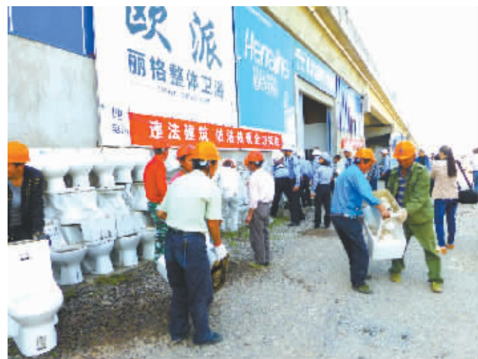
鄞州下应恒大仓库依法拆除中。
