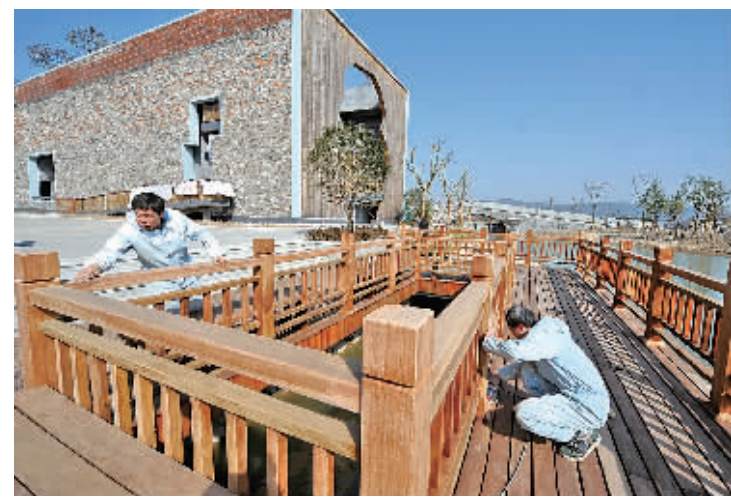
施工人员正在打磨木质亲水休闲平台。
