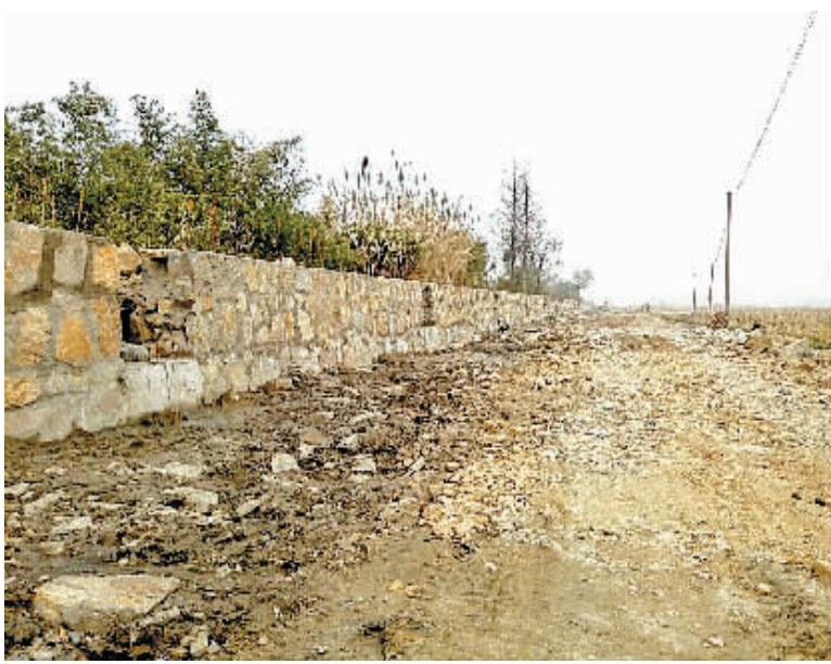
图为正在建设中的大运河慈江段防洪墙。(徐欣 黄利军 摄)
