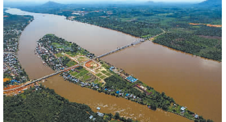
图为印度尼西亚西加里曼丹省塔扬桥全景(2015年12月3日摄)。由中国路桥工程公司承建的印度尼西亚西加里曼丹省塔扬桥2016年3月22日正式通车。塔扬桥位于印尼西加里曼丹省首府坤甸以东100公里,桥梁总长度为1350米,设计时速为80公里,桥梁结构设计使用寿命为100年。(新华社发)
