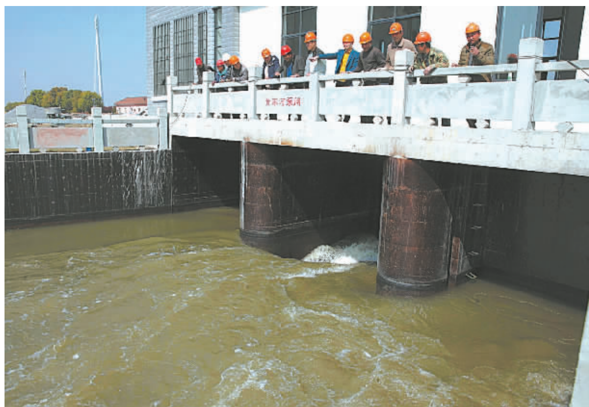
昨天,黄家河泵闸投入试运行,姚江水引入黄家河。(记者 徐文杰 摄)
